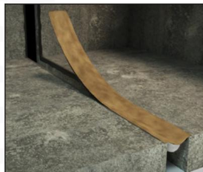
Insérer la nappe dans le joint.
