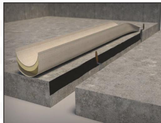
Encoller les deux côtés à l'intérieur du joint sur une hauteur de 90 mm environ.
