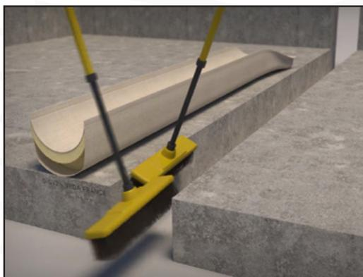
Dégarnir, si besoin, le corps du joint (polystyrène, carton alvéolaire, etc.). Les surfaces doivent être propres et sèches. Procéder au dépoussiérage à l'aide d'une brosse, d'un balai ou d'un aspirateur.
