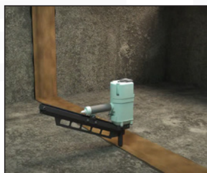
Fixer au cloueur pneumatique les ailettes tous les 20 cm.
